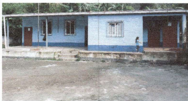
Foto 6: Repello y pintura del muro
