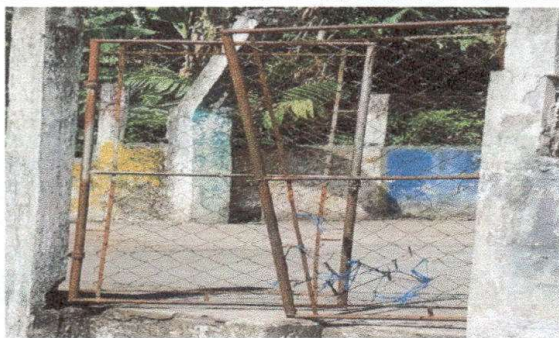
Foto1: Sustrucción de portón de metal.
