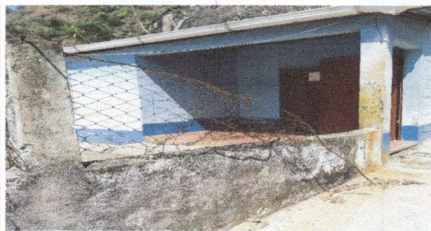
Foto 4: Reparación de muro perimetral de block.
