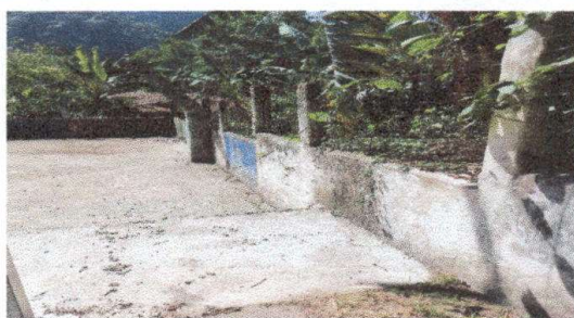
Foto 5: Reparación de planchas de concreto de patio
