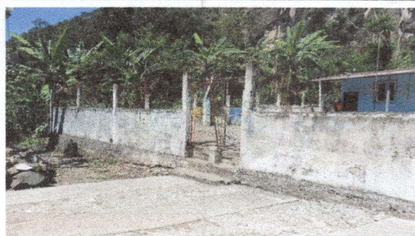
Foto 2: pintura en muros exteriores e interiores
